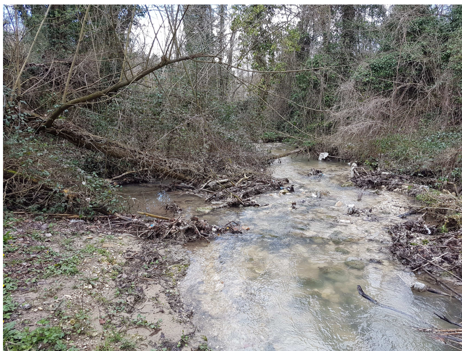
Foto n°8 – Erosione della scarpata a ridosso dell'ingresso dell'impianto
