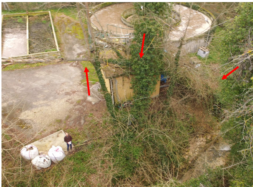
Foto n°7 – Albero ad alto fusto che incombe sul fabbricato servizi
