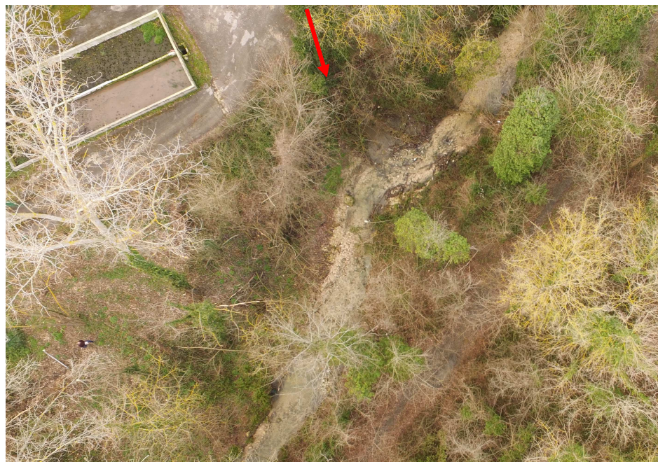
Foto n°5 – Erosione della scarpata a ridosso dell'ingresso dell'impianto
