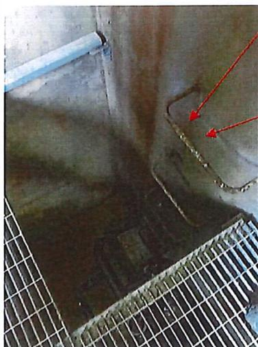
4. installare corrimano sulla scala di accesso (presenza di dislivello non protetto)
