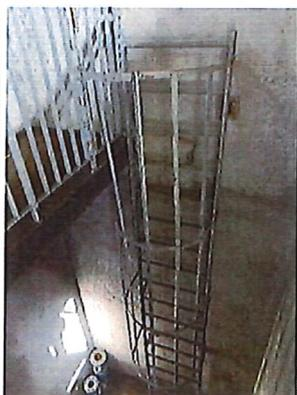
criticità: la scala non è utilizzabile dal prelevatore qualora debba portare a mano il materiale per il campionamento
